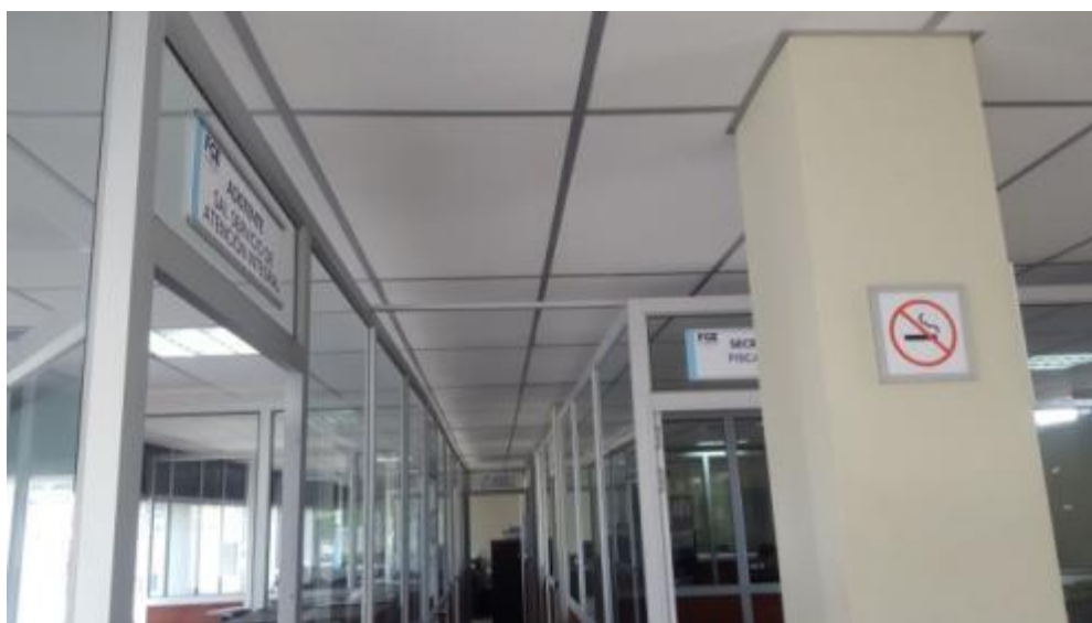
“Instalación de dos sistemas de centrales de aires y tumbado en las Fiscalías 3, 4 y 5 del Cantón Santa Elena”.
